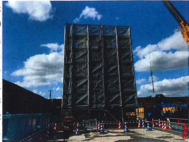
(洋上風力発電のグラウトモックアップ試験)
